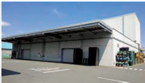
危険物倉庫 (平屋部分)
