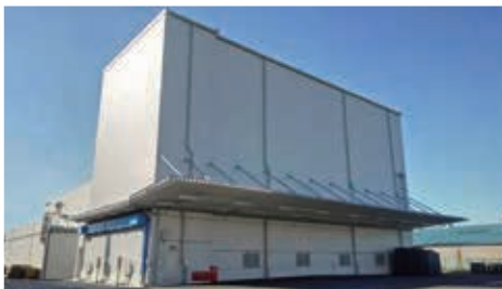
危険物倉庫 (立体部分)
